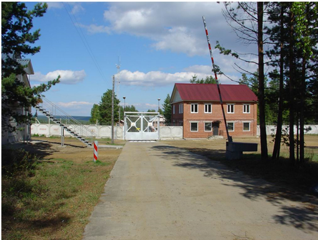
Рисунок 2.2.4.1 - Контрольно-пропускной пункт ПХРО Сибирского филиала «ФГУП «РАДОН»
