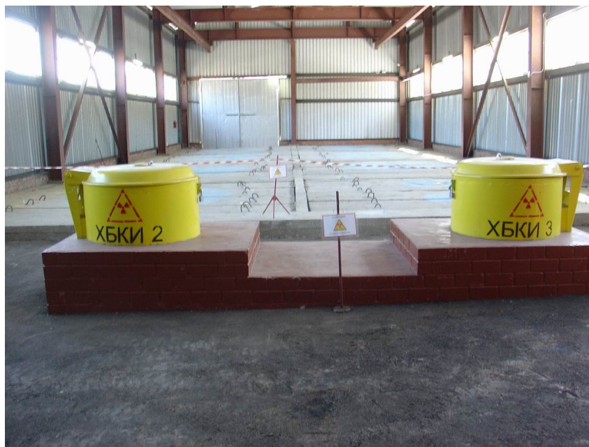
Рисунок 2.2.3.6 - Хранилища ХБКИ-2 и ХБКИ-3. Внутри здания 21.
