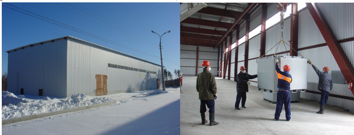
Рисунок 2.2.3.4. - Внешний вид хранилища ХТРО-3 (здание 20).
