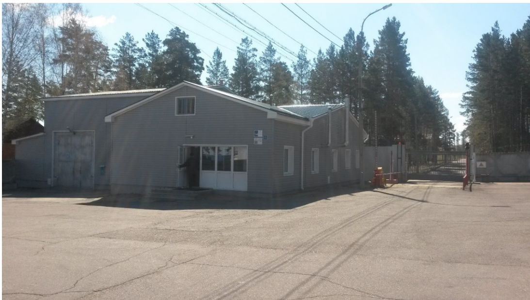
Рисунок 2.2.3.8- Здания 14 и 15 – санпропускник и пункт дезактивации. Въезд с Зону возможного загрязнения ПХРО Сибирского филиала ФГКП «РАДОН»
